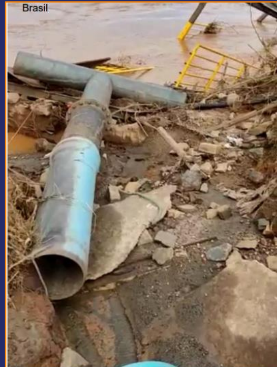
Figura 4: Passarela da captação flutuante após o nível do rio baixar
